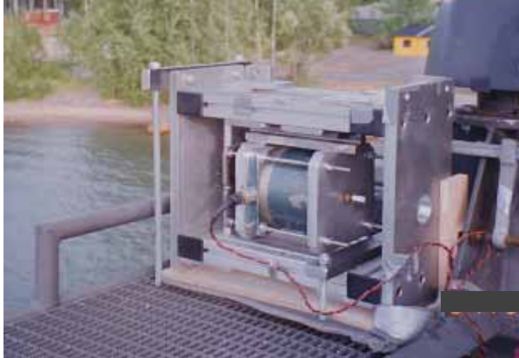
Kuva 5. Sähködynaamiseen täristimeen perustuva aktiivinen massavaimennin asennettuna ohjusveneen mastoon.
