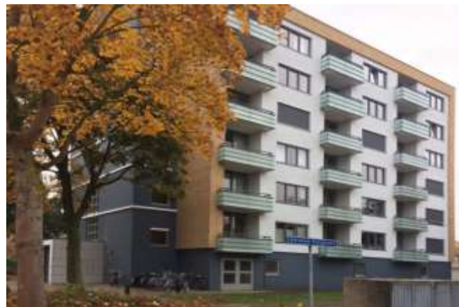
NOM Renovation - De Bilt
