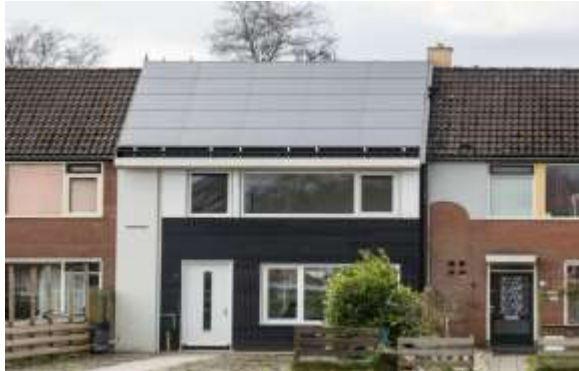
NOM renovation Nieuw-Buinen
