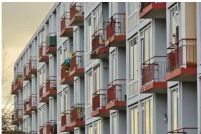
NOM Renovation - Utrecht
